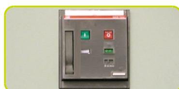
GMB2 - 4-х полюсный моторизованный автоматический выключатель генератора A 4000
