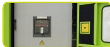
GCB2 - 4-х полюсный автоматический выключатель генератора A 1600
