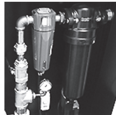
Рисунок 4-2. Коалесцирующий фильтр и ИПД
